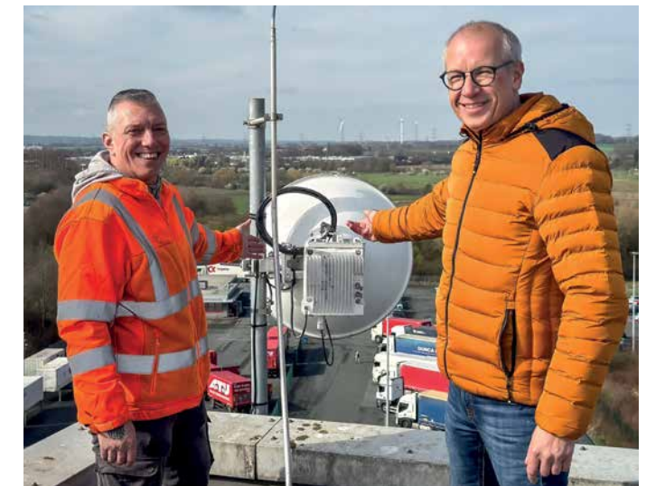
Thomas Hennecke, r., Vertriebsleiter der Region Südwestfalen bei DOKOM21, und Friedrich Richs, Mitarbeiter bei ATU, mit der installierten Richtfunkantenne.
